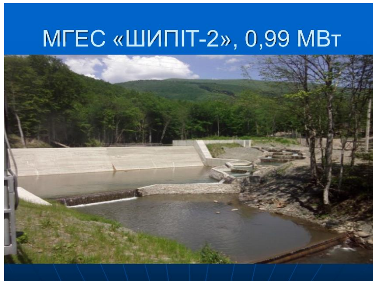
Рис. 2. Водозабір з рибиходом для міні-ГЕС «Шипіт-2» на річці Тур'я Закарпатської області
