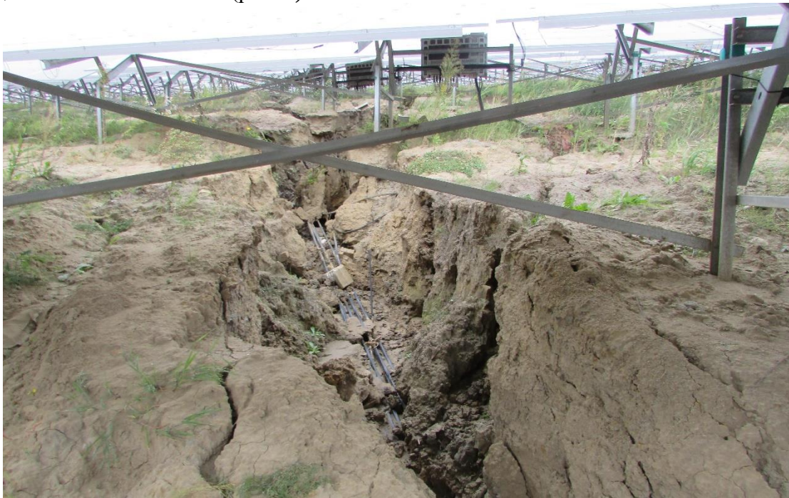
Рис. 9. Прояв глибокого яркового розмиву ґрунтового масиву, в межах якого інстальовані сонячні панелі, іноді до досить значної глибини
