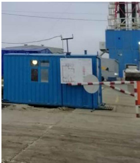
Рис. 1. Фотознімок на ділянці буріння свердловини 888. Опрацьовано фрагмент фотографії в правій нижній частині знімка.
