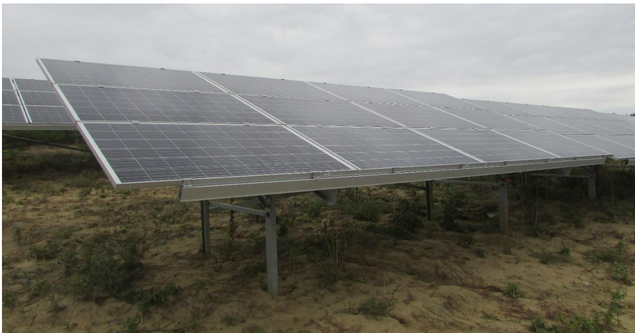
Рис. 3. «Ефект парасолі» сонячних панелей – атмосферні опади не зволожуть під ними ґрунт
