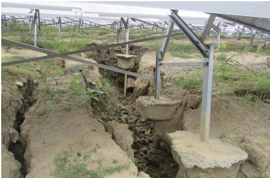
Рис.10. Ефект змін інженерно-геологічних умов за умов глибокого яркового розмиву ґрунтового масиву, що призводить радикальної зміни рельєфу під фундаментами, утворення водоройн специфічних форм та різних розмірів, зумовлює втрату опорами несучої здатності.
