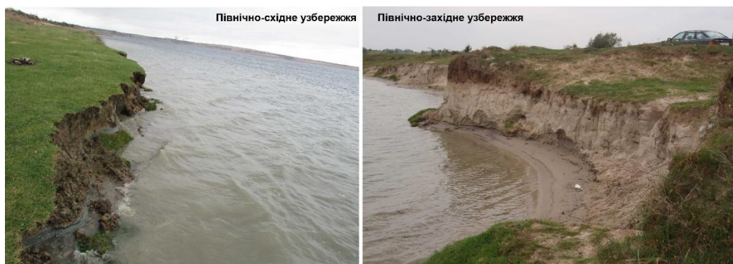
Рис. 2. Прояви хвильового розмиву піщаних берегів Яворівського озера на ділянках північно-східного та північного західного узбережжя із порушенням ґрунтово-рослинного покриття, абразією, утворенням кліфів, обвалів та піщаних пляжів
