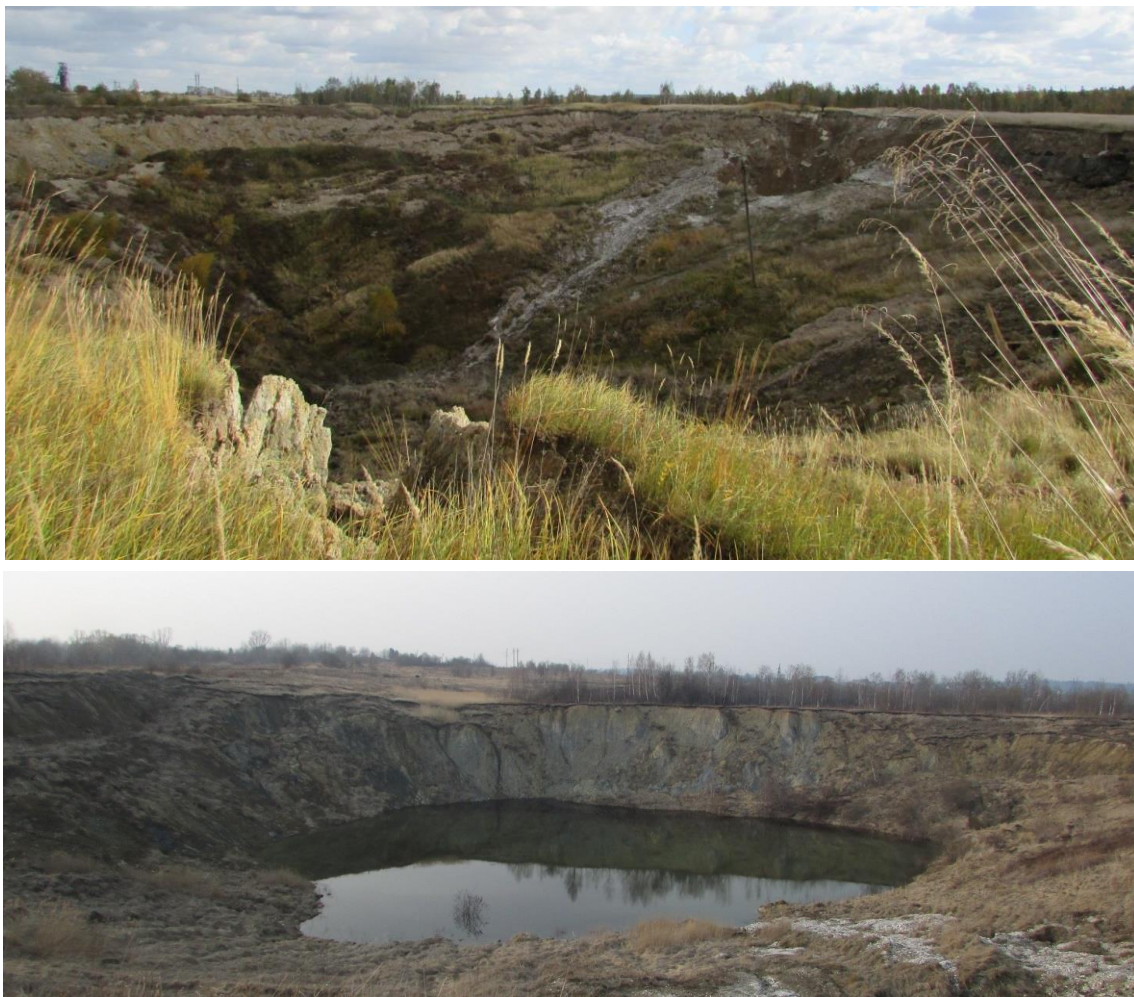
Рис. 3. Провал № 27 на пласті № 10 Пд-Сх рудника № 2 Стебницького ГХП "Полімінерал" в районі камер № 108-109-110-111-112-113, який стався 30 вересня 2017 року, 0 год. 46 хв (вгорі) та карстове озеро на місці цього провалу станом на 2021 рік (внизу)
